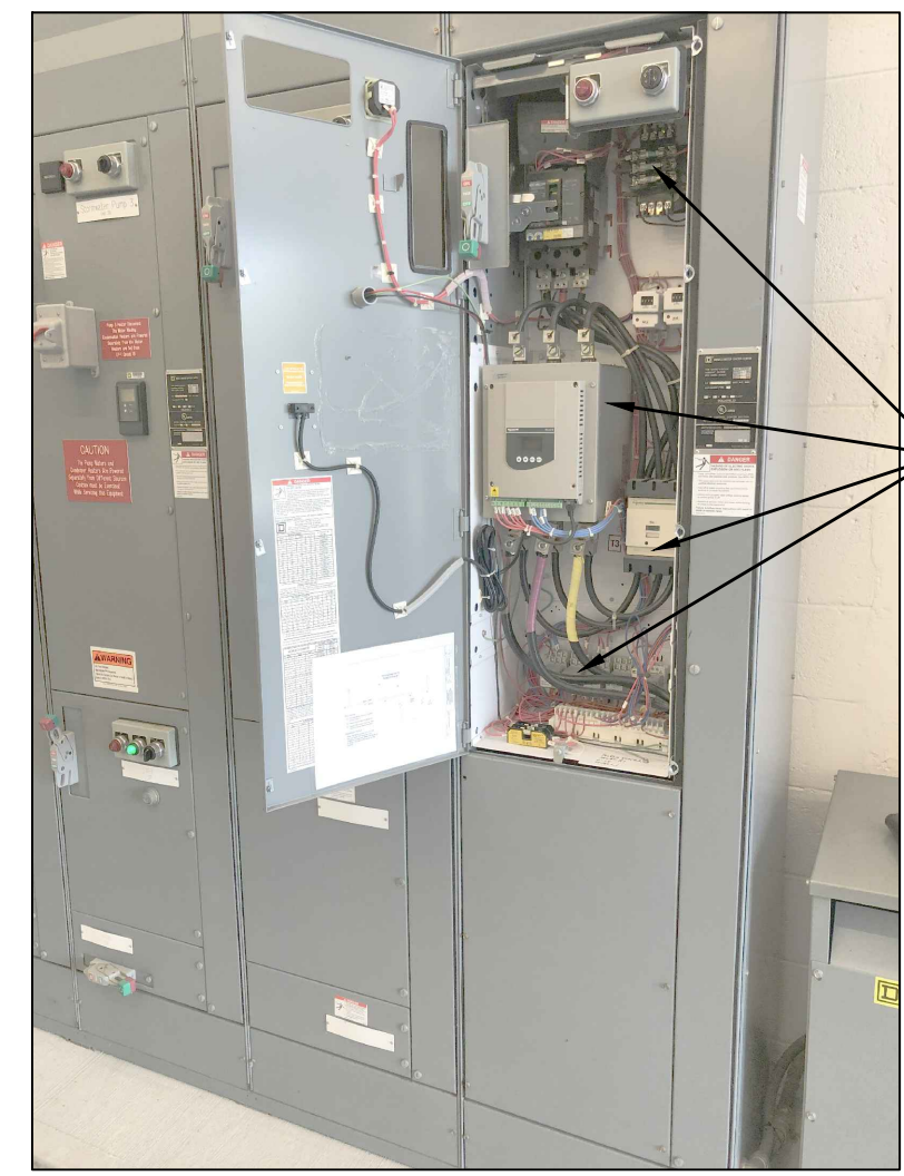
MOTOR #1 MCC BUCKET N.T.S.
